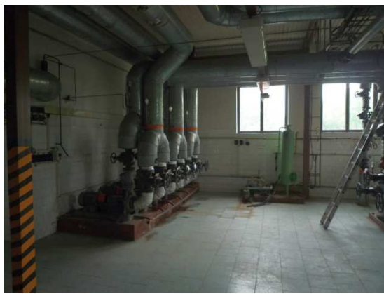
kotelna OKD před rekonstrukcí
