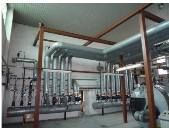
kotelna OKD před rekonstrukcí
