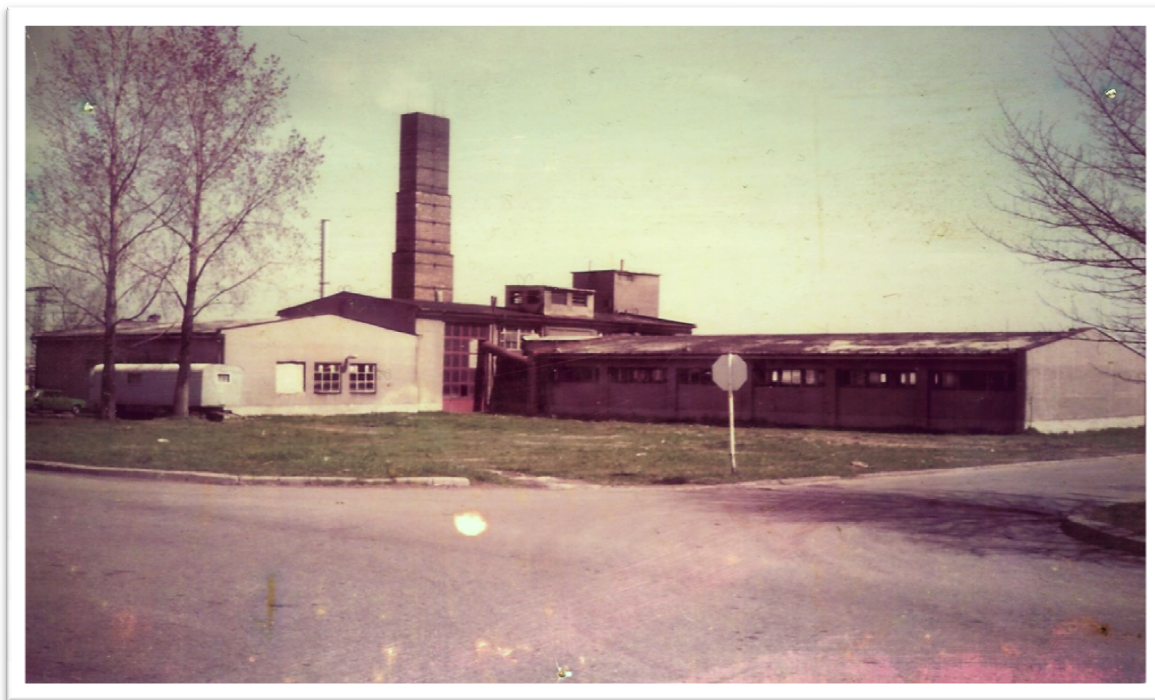
Uhelná kotelna na ulici Čs. armády v Hlučíně
