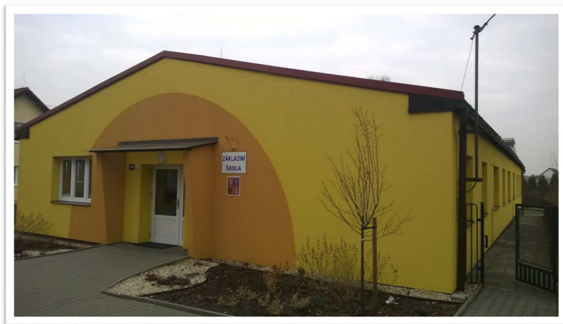
Budova základní školy v Bobrovníkách s lokálním vytápěním
