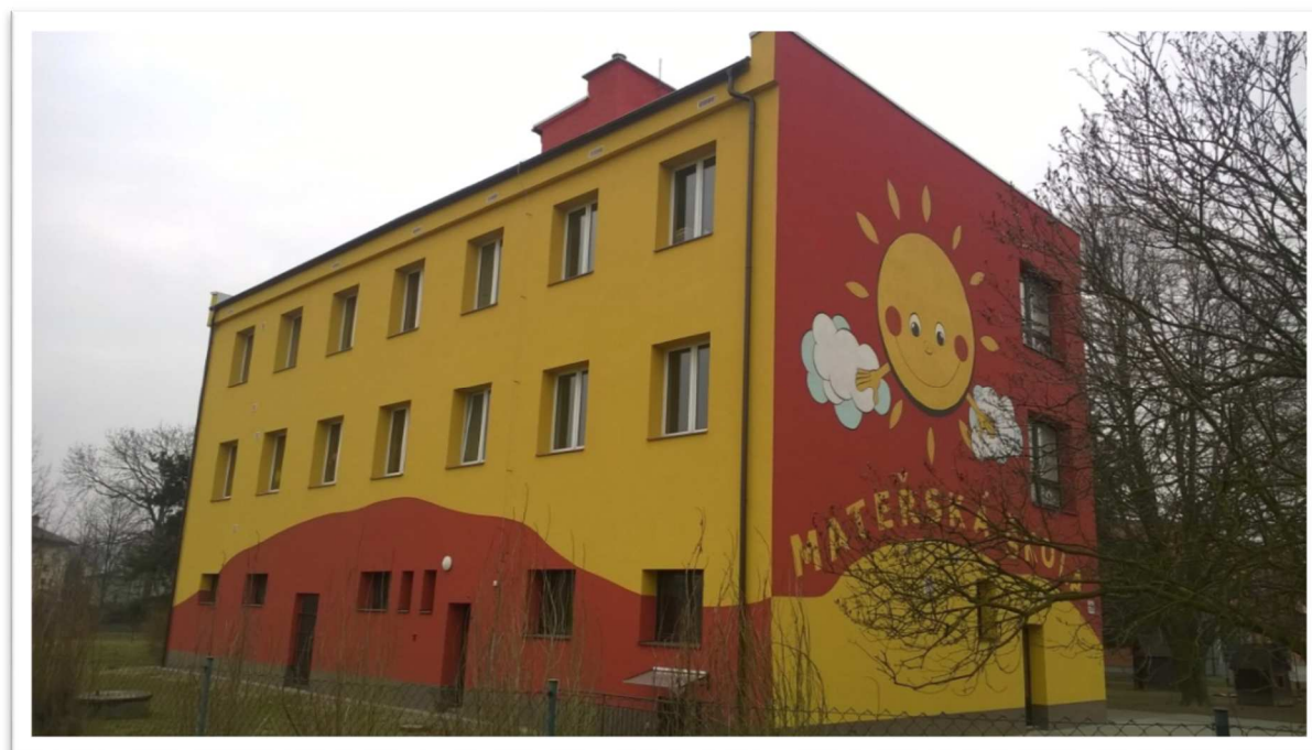
Rekonstruovaná budova mateřské školy v Darkovičkách s lokálním vytápěním
