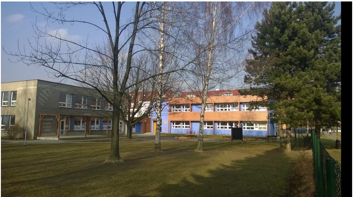
Budovy mateřské škola Cihelní v Hlučíně s CZT vytápěním
