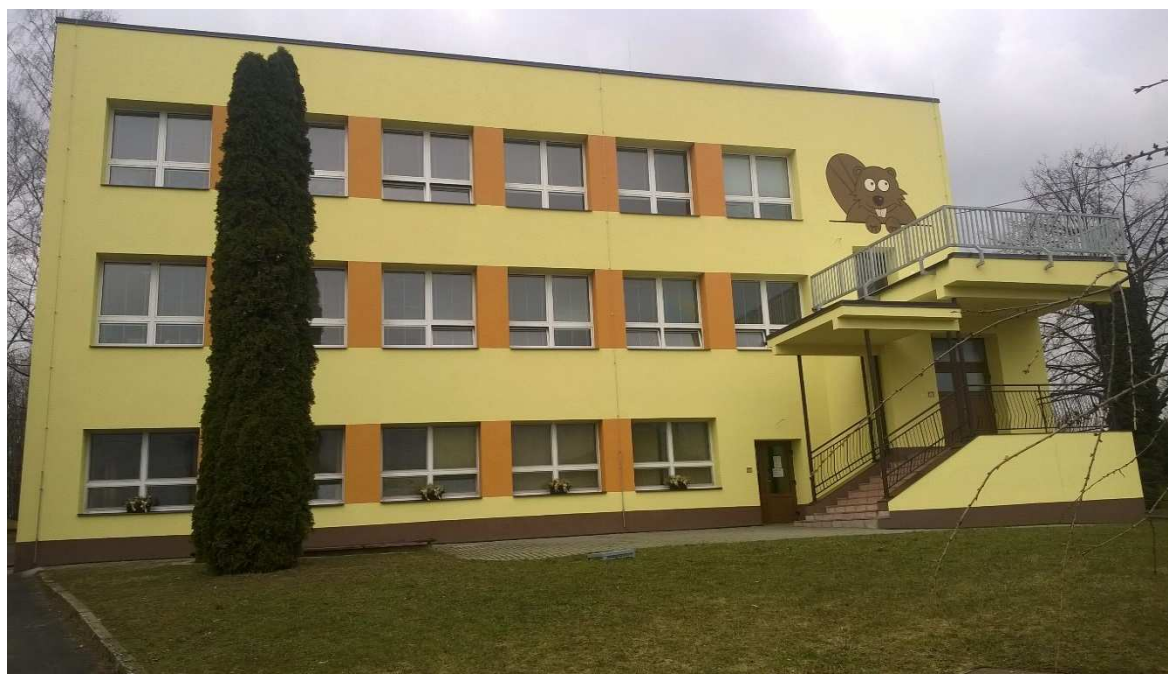
Rekonstruovaná budova mateřské školy v Bobrovníkách s lokálním vytápěním
