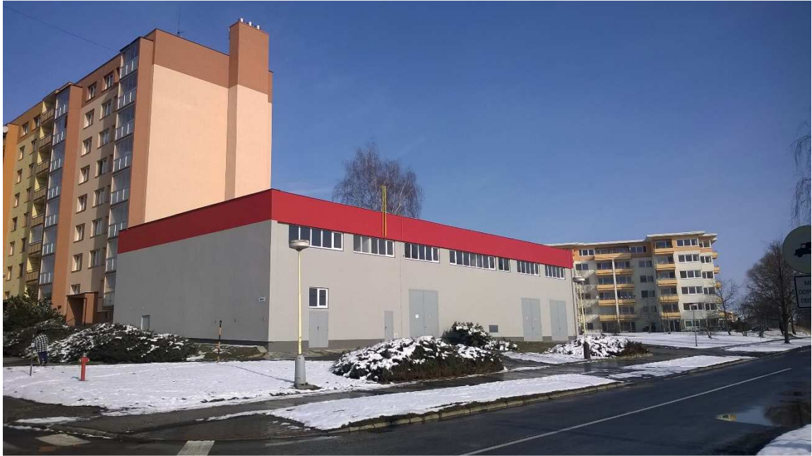
Rekonstruovaná budova kotelny Dukelská
