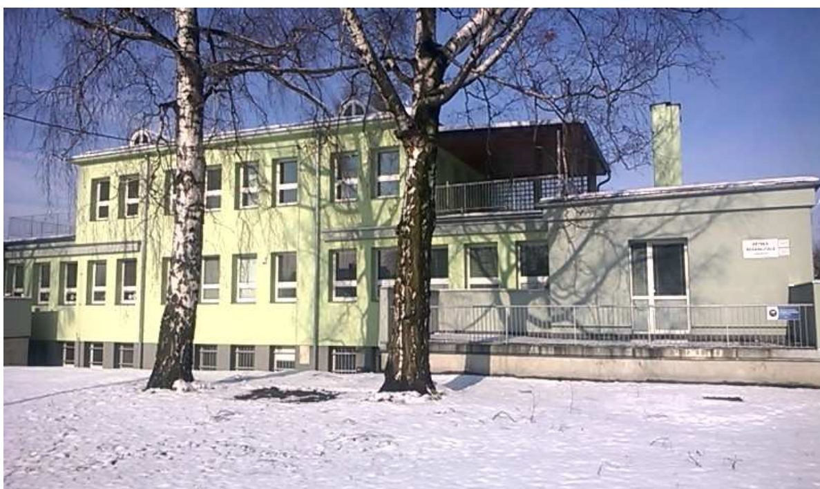
Rekonstruovaná budova dětské rehabilitace v Hlučíně s lokálním vytápěním
