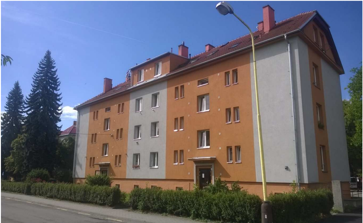
Bytový dům na ulici Zahradní – Dr. E. Beneše
