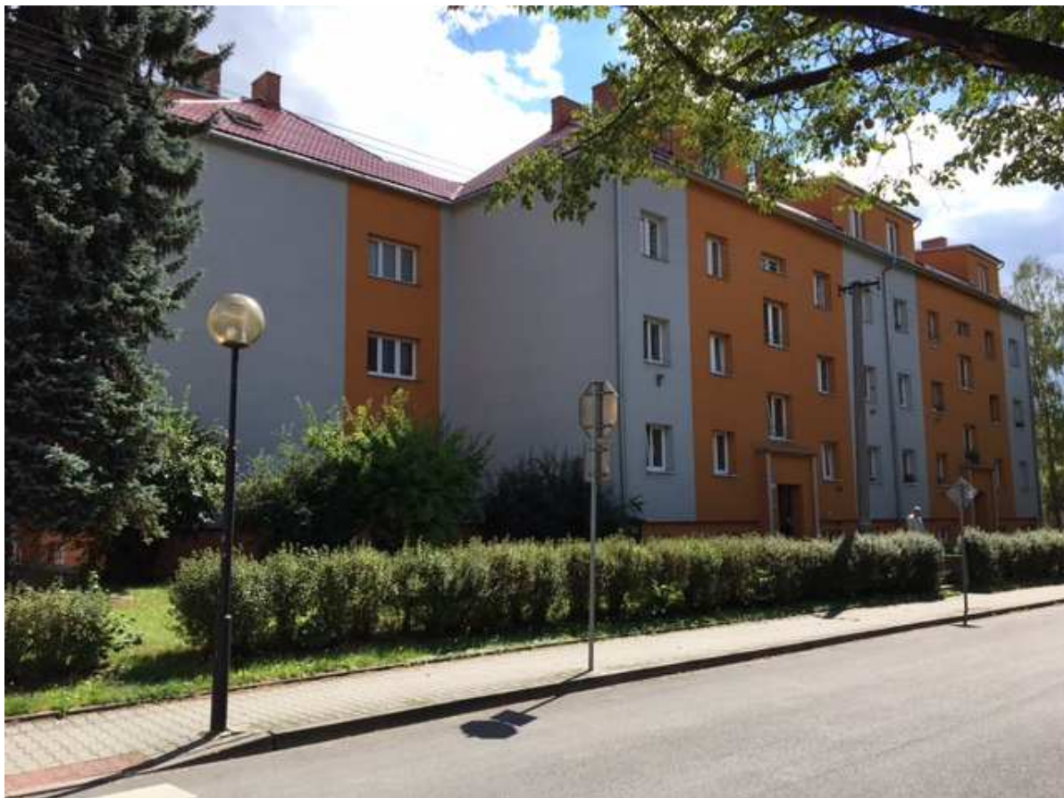
Rok 2017 - Bytový dům na ulici Zahradní 16 – Dr. E. Beneše 10
