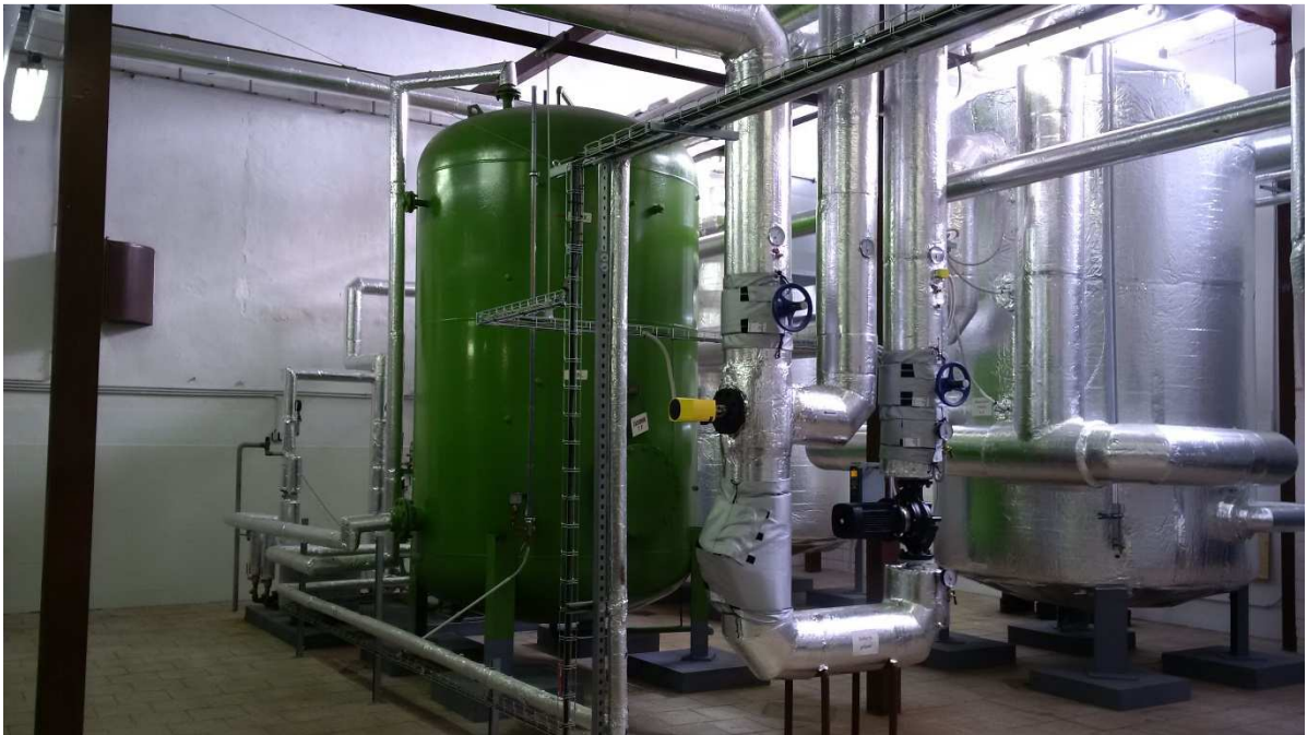
Rok 2017 – rekonstrukce kotelny Dukelská
