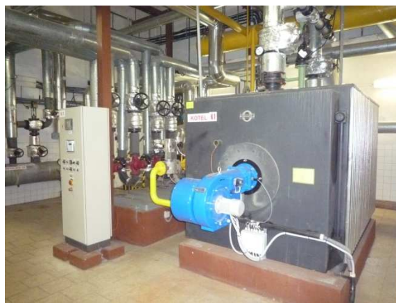
kotelna Dukelská – nový automatický plynový hořák s ventilátorem APH-M 10 PZN – 600 kW
