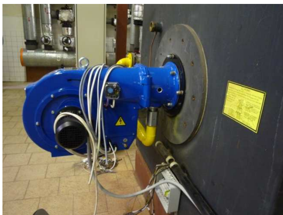
kotelna Dukelská – nový automatický plynový hořák s ventilátorem APH-M 10 PZN – 600 kW
