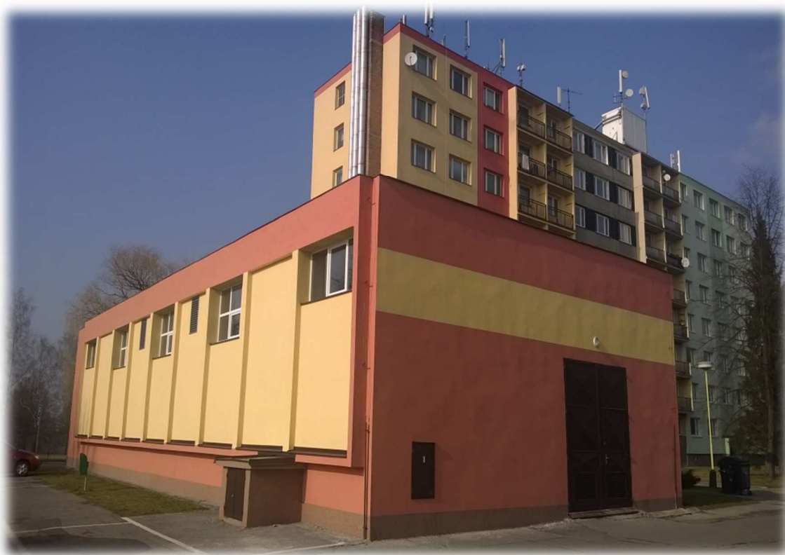
Budova kotelny Cihelní po rekonstrukci
