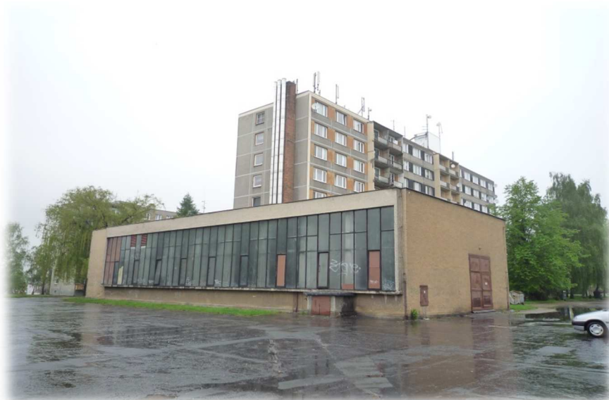
Budova kotelny Cihelní před rekonstrukci
