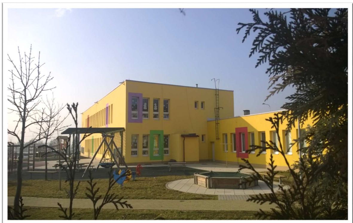
Rekonstruovaná Mateřská škola na Severní ulici v Hlučíně s CZT vytápěním
