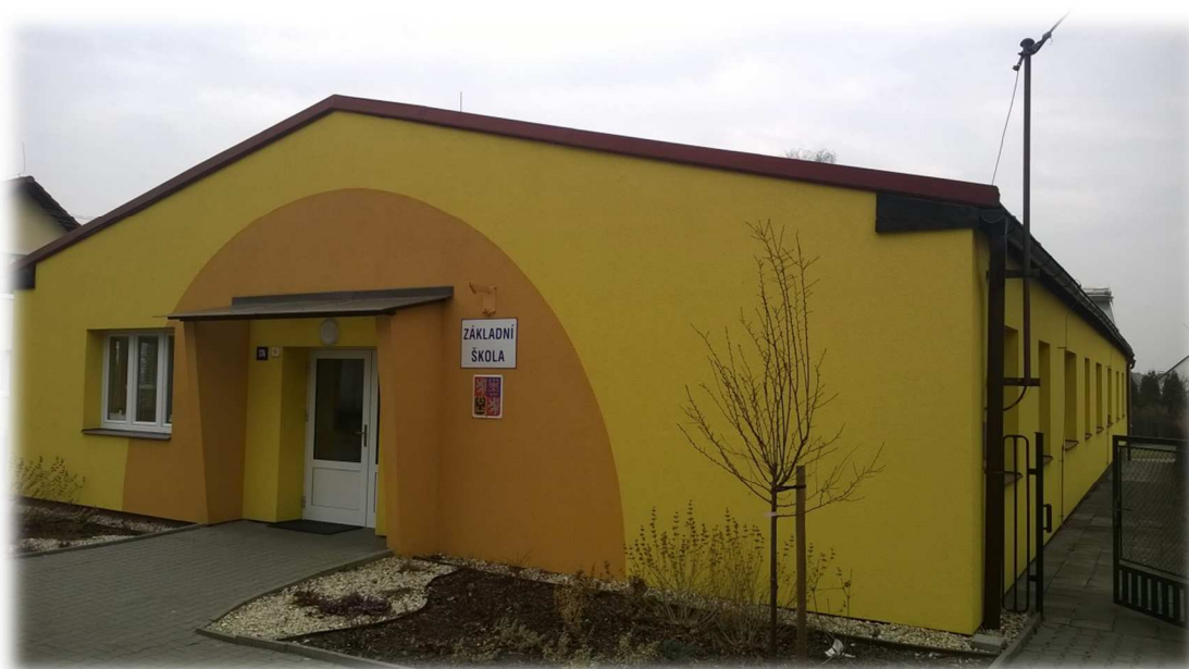
Rekonstruovaná budova základní školy v Bobrovníkách s lokálním vytápěním
