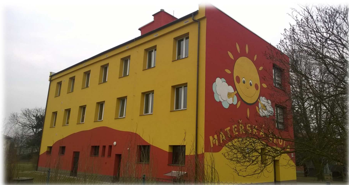
Rekonstruovaná budova mateřské školy v Darkovičkách s lokálním vytápěním
