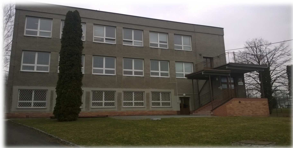
Budova mateřské školy v Bobrovníkách s lokálním vytápěním
