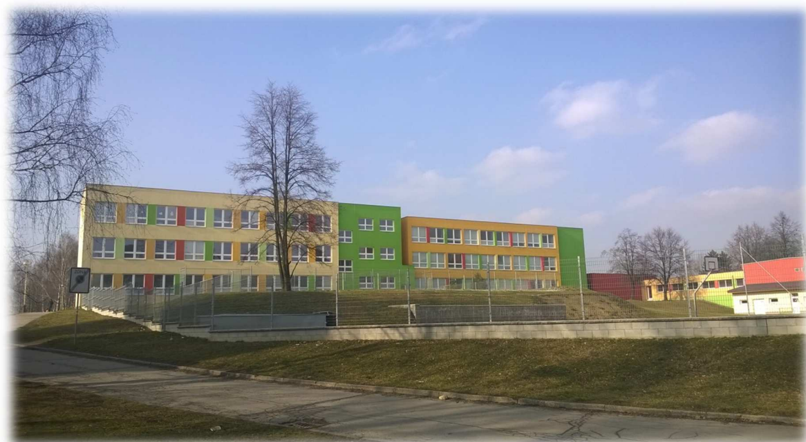
Základní škola Rovniny v Hlučíně s CZT vytápěním
