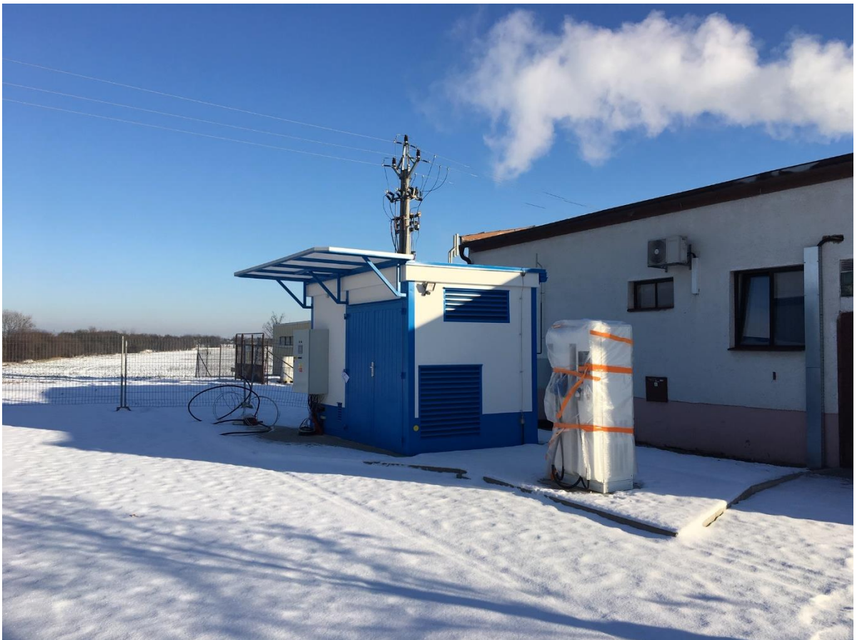
Prosinec 2018 – plnicí stanice CNG v průběhu výstavby
