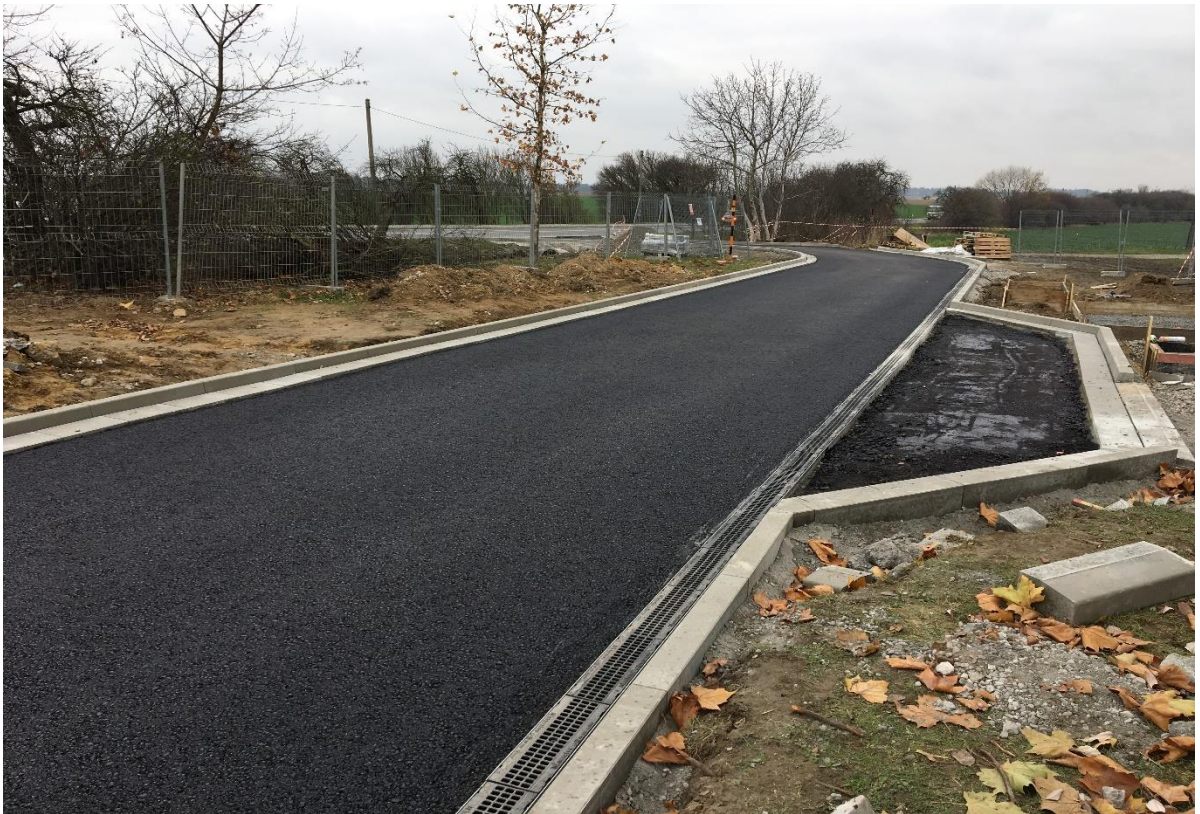
Říjen 2018 – výstavba obslužné komunikace v průběhu výstavby plnicí stanice CNG
