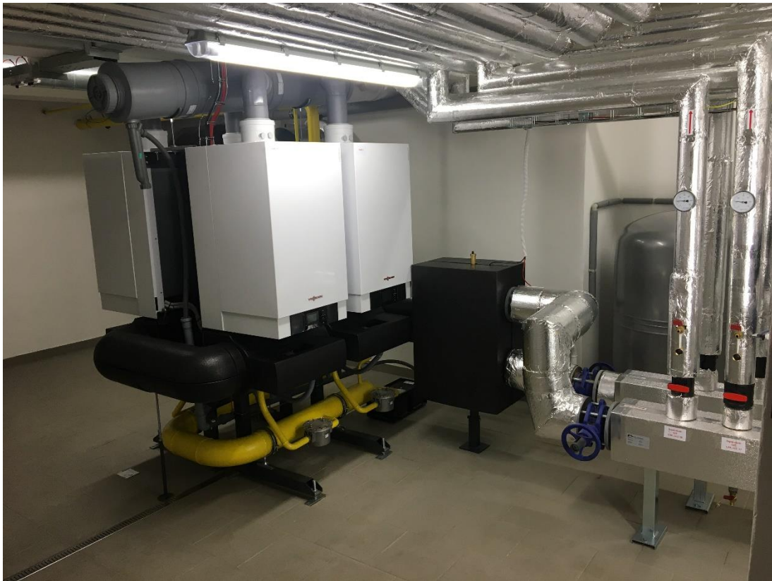
2020 – rekonstruovaná kotelna v Kulturním domě Hlučín
